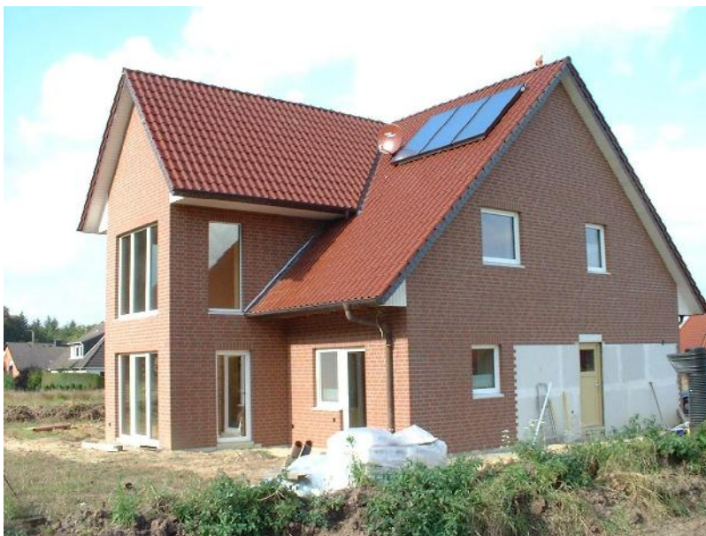
27624 Drangstedt PASSIV-HAUS, HALLERDACH® PASSIV
