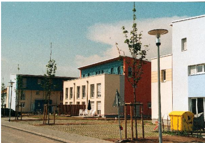
65428 Rüsselsheim 80 RH PASSIV- Wohnanlage HALLERDACH® KOMBI „C“
